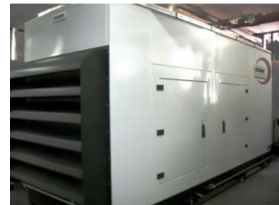
Grupo Gerador - CESPE Geração de emergência para o CESPE Fabricante (motor/gerador): Mercedes-Benz/ Stamac Tensão: 380 V Potência (stand-by): 450 kVA Potência (contínua): 250 kW
