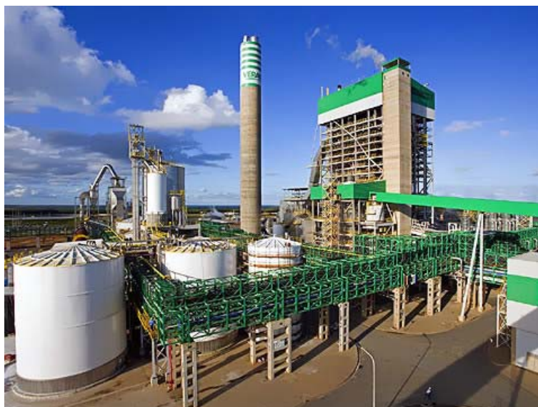
Figura 3-5 Central de cogeração qualificada Veracel, com 117 MW de capacidade utilizando licor negro como combustível, em Eunápolis/BA (foto: Veracel Celulose S.A.).
