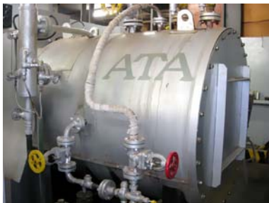
Caldeira elétrica Vapor saturado para o RU Fabricante: Ata (Aalborg), 1979 Potência: 432 kW Produção de vapor: 500 kg/h Pressão de trabalho: 10,55 kgf/cm 2 Pressão de utilização: 5,27 kgf/cm 2
