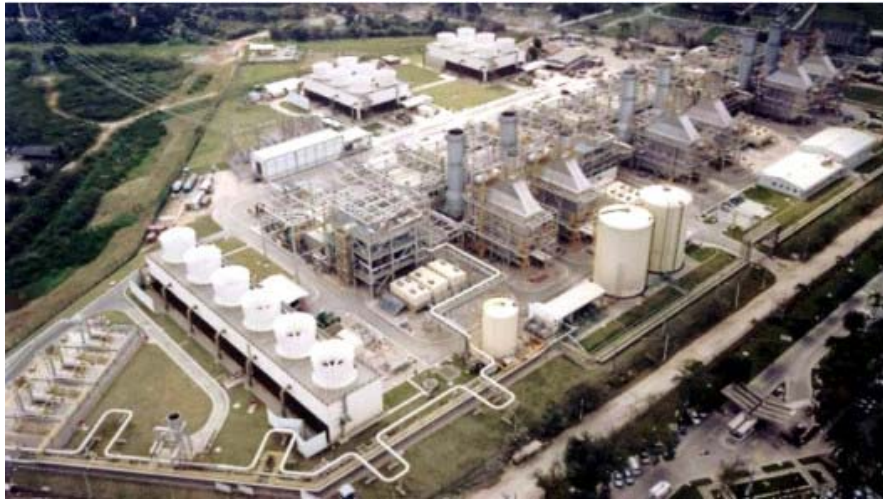
Figura 2-19 Central cogeneradora TermoRio, 1.040 MW, Duque de Caxias-RJ. (Foto: TermoRio S.A., 2004)
