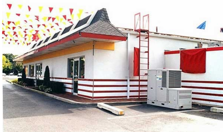
Figura 2-24 Sistema de cogeração utilizando célula a combustível tipo PEFC, alimentando uma lanchonete nos EUA.
