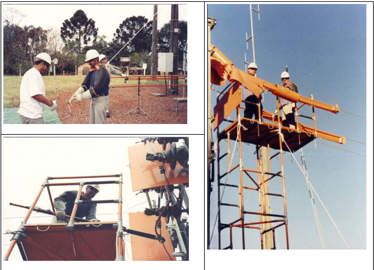
Figura 1: Manutenção em rede energizada ou “linha viva”.
