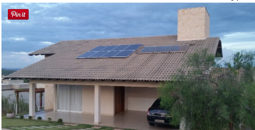
Casa equipada com painéis de microgeração de energia (e) e aquecimento solar (d)
