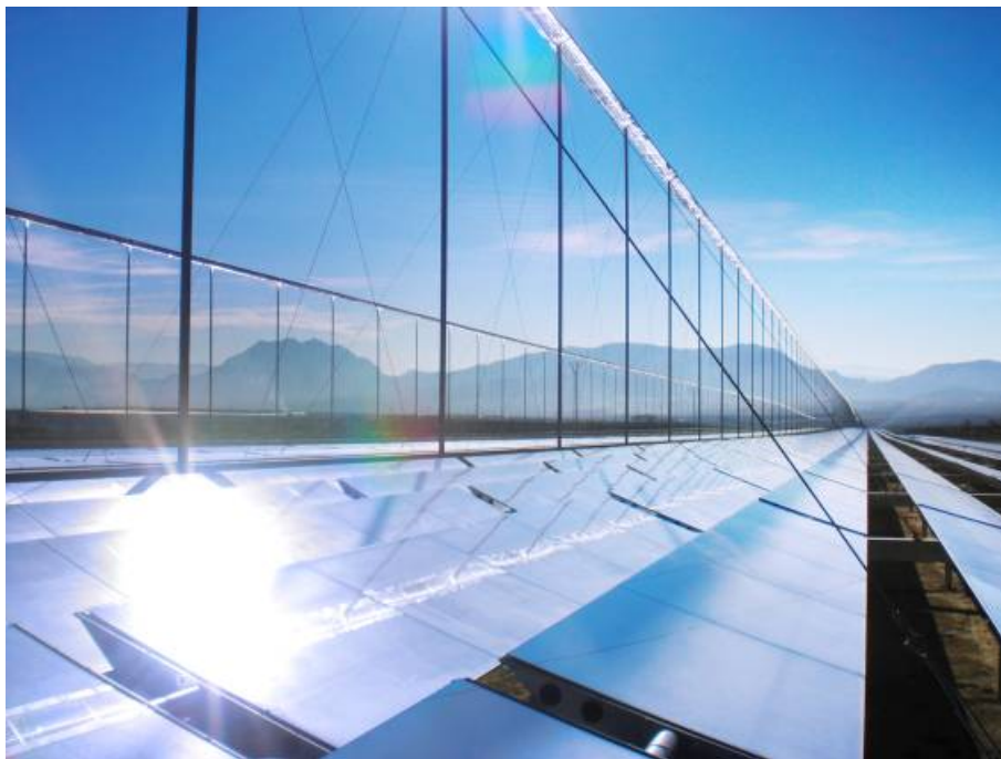
Figura 3: Tecnología de reflectores lineales tipo Fresnel
