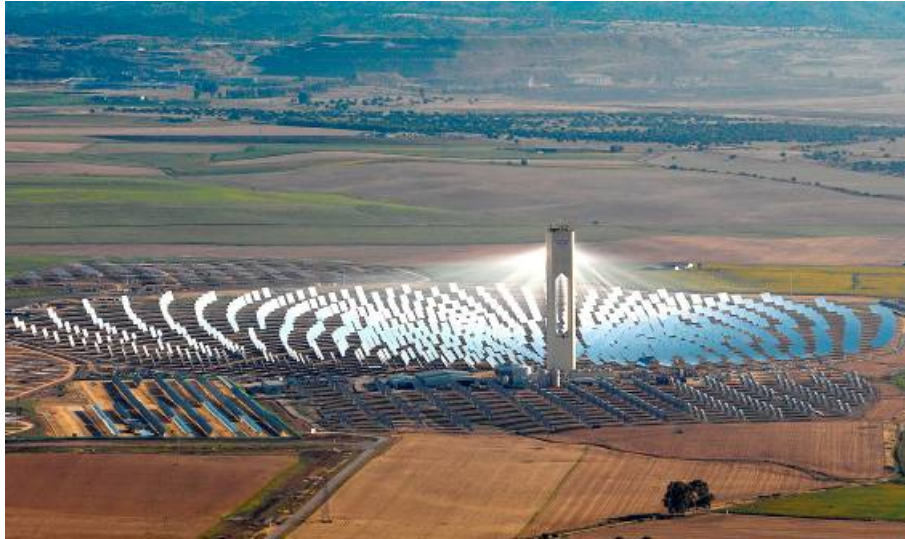
Figura 2: Tecnología de Receptor Central
